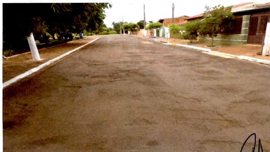
FOTO – 05 – Rua Aristeu Pereira da Silva
