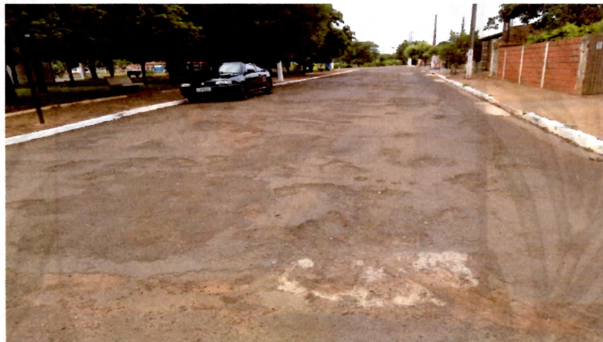
FOTO – 04 – Rua Aristeu Pereira da Silva
