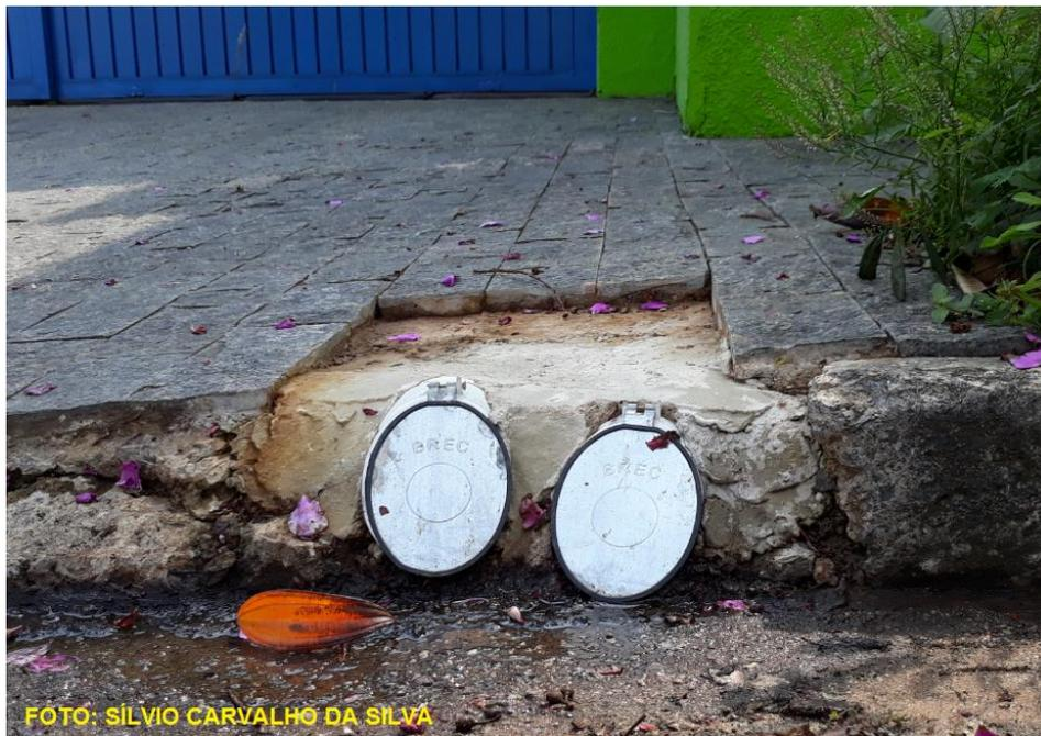
Válvula de retenção. Evita o acesso do escorpião para dentro da tubulação.
